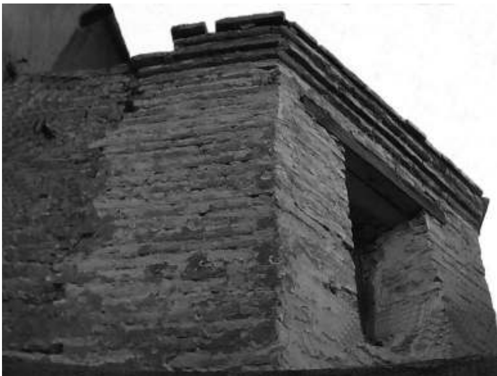
Figura 17. El ábside visto desde fuera, en el curso de los trabajos de restauración arquitectónica. Foto: Lina Fernández.
