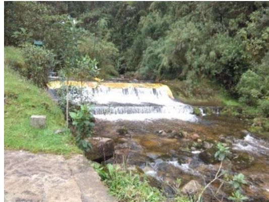
Figura 25. Estructuras de captación sobre quebradas Sistema Rio Blanco Fuente: Elaboración propia
