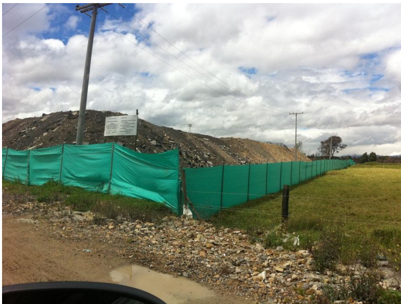
Figura 9 Lindero norte de la planta de procesamiento.
