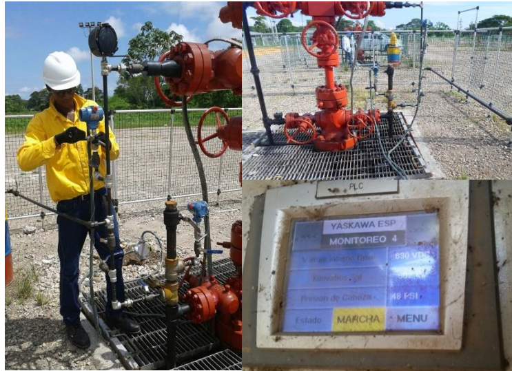
Figura 20 Montaje instrumentos en pozos productores
