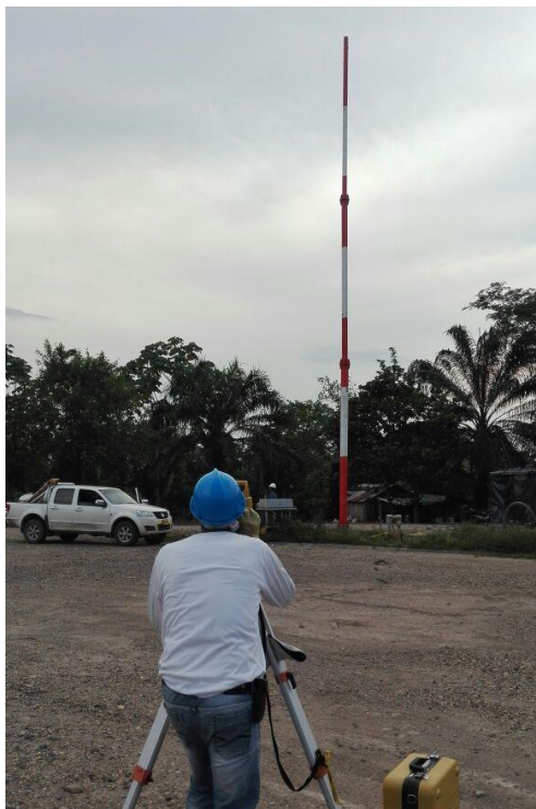
Figura 22: Montaje de Mástiles de comunicaciones
