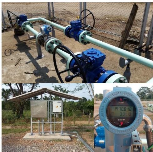
Figura 21 Montaje instrumentos en pozos inyectoros
