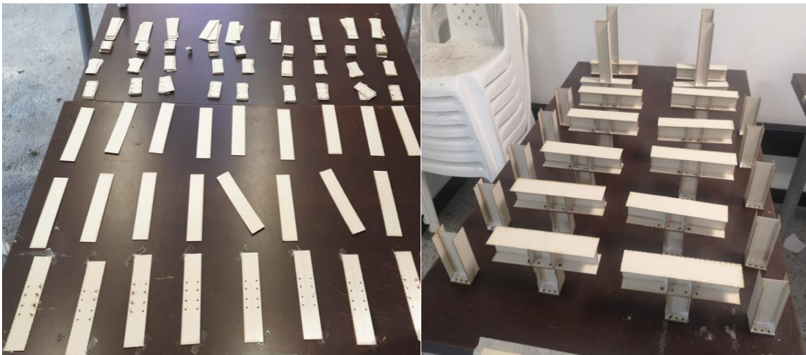
Ilustración 16 – Proceso de construcción Probetas RBS Des. y RBS Conv.
