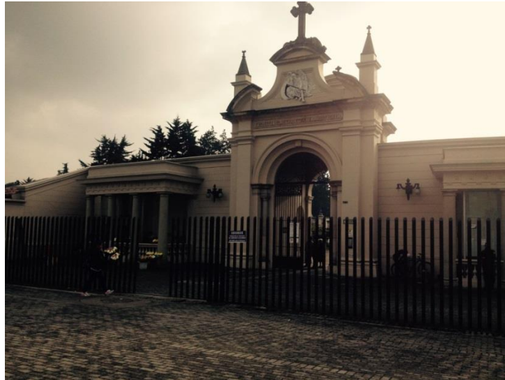
Figura 16. Marco de entrada a la elipse del Cementerio Central
