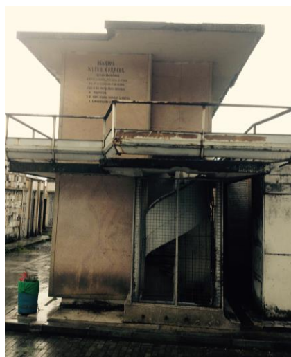
Figura 7. Fachada de los osarios "El Caracol".
